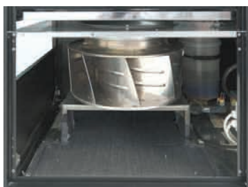
Рис. 4. Монтаж вентилятора внутри агрегата
