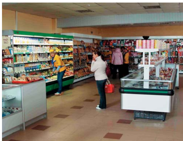
Магазин в Белоруссии. Холодоснабжение от агрегата LHV6/4FC-5/F1Y: холодопроизводительность на низкотемпературном уровне 2,5 кВт, на среднетемпературном – 9 кВт
